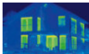
Tras la instalación profesional de nuevas ventanas del sistema Schüco LivIng, la termografía demuestra el alto beneficio energético de la inversión. La pérdida de energía original se elimina casi por completo.
