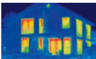
Fotos de infrarrojos y termografías muestran claramente por dónde una casa pierde energía de forma incontrolada. Rojo significa calor y por tanto pérdida de energía.
